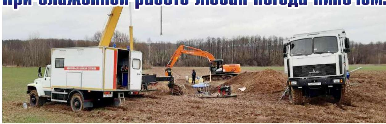
Перекладка газопровода среднего давления к агрогородку Пархимовцы Берестовицкого района протяженностью 6,5 км была выполнена в октябре-ноябре 2019 года согласно Плану модернизации газовых сетей на 2019 год. Еще в процессе строительства решался вопрос, каким образом выполнить врезку вновь построенного газопровода в действующий стальной газопровод диаметром 300 мм без прекращения подачи газа потребителям.
